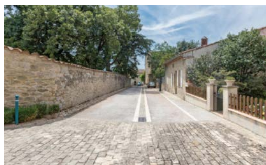
Exemple de traitement de sol différencié :
