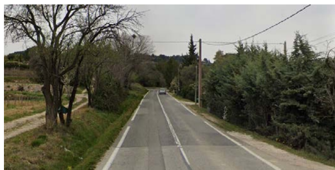
Aucun aménagement existant pour les modes doux RD559B
