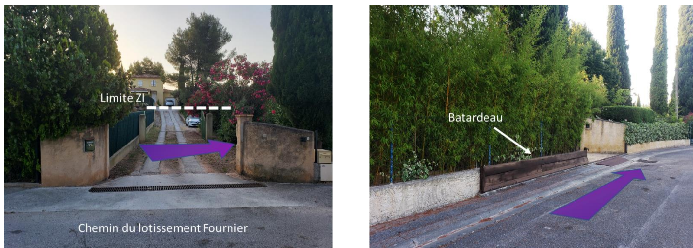
Figure 13 : À gauche, l'axe de ruissellement du vallon du Fournier / à droite, photo de batardeau dans le lotissement
