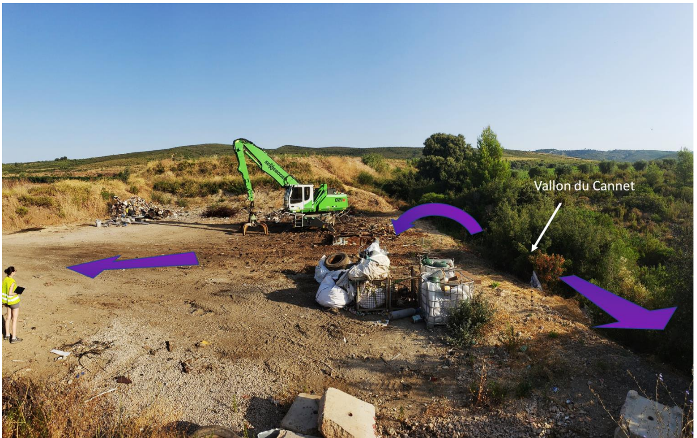
Figure 16 : Vue vers l'amont du vallon du Cannet à l'est du vallon de Capucine
