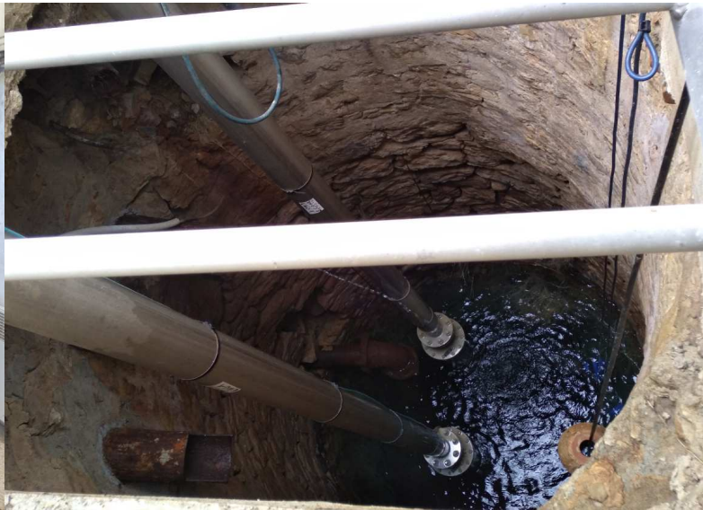
Vue intérieure du forage
