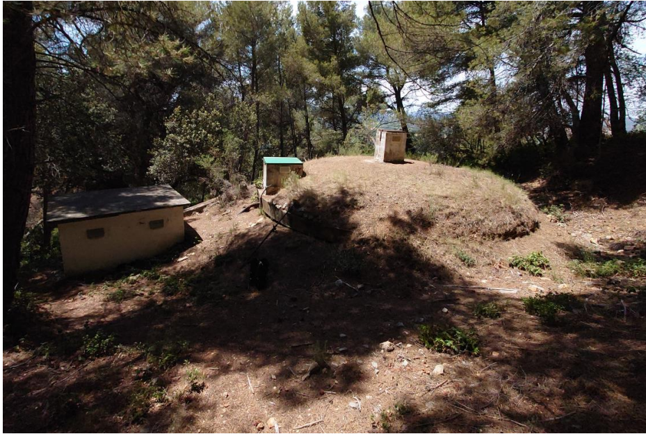
Figure 26 : Vue extérieure du réservoir du Canadeau
