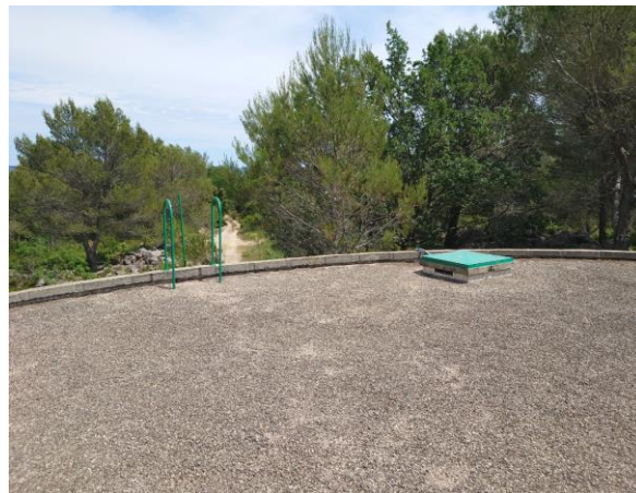
Figure 21 : Toit de la cuve de 1 000 m 3 du réservoir Le Camp
