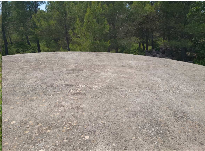
Toit de la cuve
