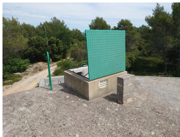
Figure 22 : Toit de la cuve de 500 m 3 du réservoir Le Camp
