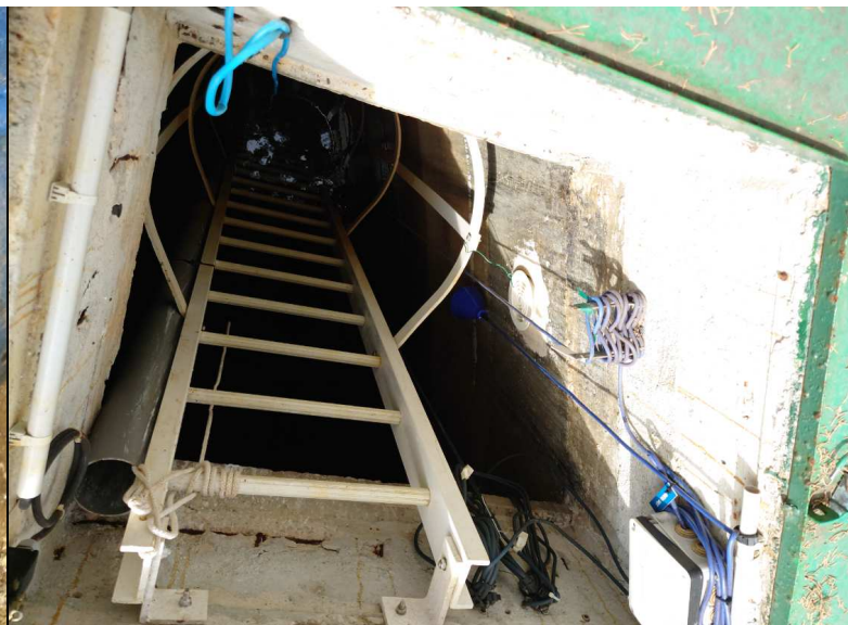
Intérieur de la cuve
