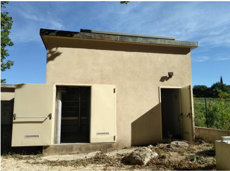
Vue extérieure du bâtiment de traitement
