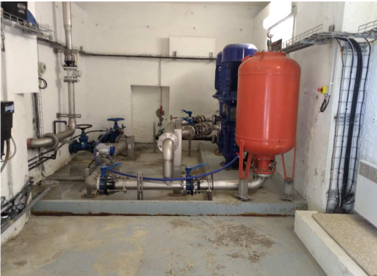
Chambre de vannes
