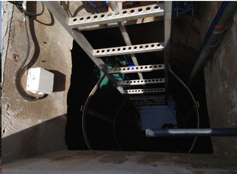
Vue intérieure de la cuve
