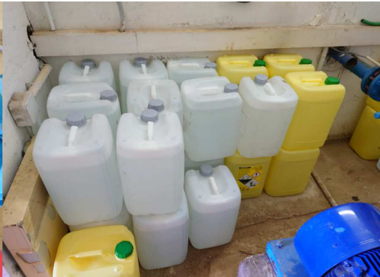
Stockage des produits de traitement
