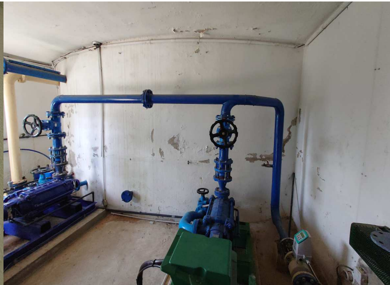
Chambre de vannes
