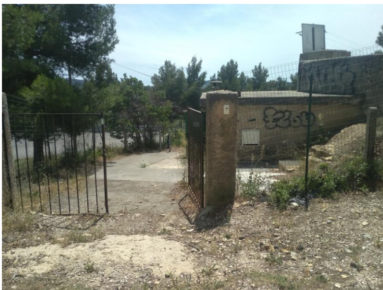
Figure 23 : Vue extérieure du réservoir de Sainte Anne
