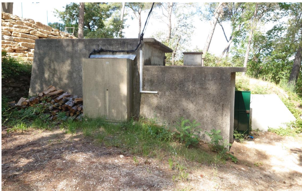
Figure 25 : Vue extérieure du réservoir du Cas
