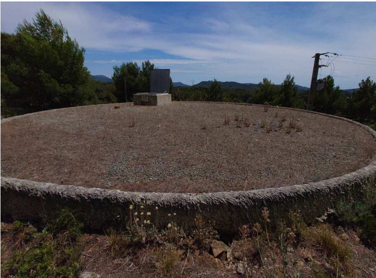
Toît de la cuve
