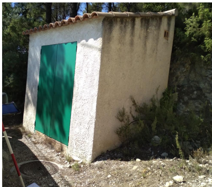
Figure 27 : Vue extérieure du surpresseur Pin Vert
