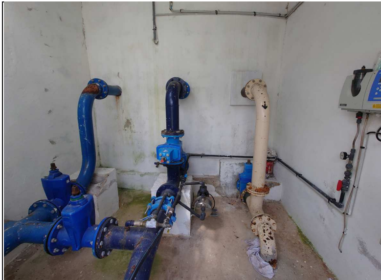
Chambre de vannes
