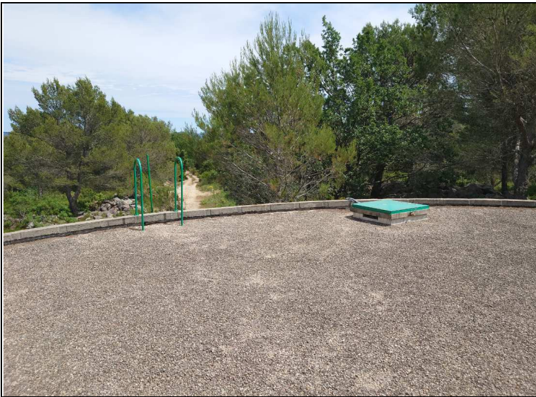
Toît de la cuve
