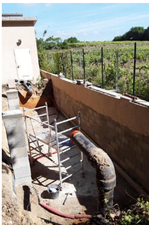
Figure 19 : Travaux menés en 2020 pour rétablir la cuve d'eaux sales (Source : RAD 2020)
