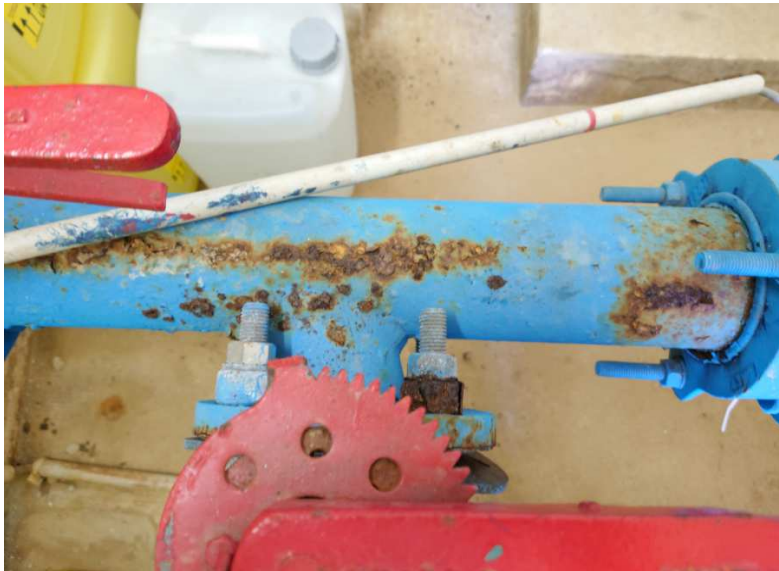
Traces de corrosion
