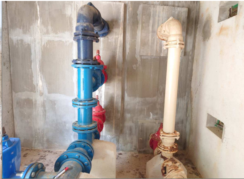
Chambre de vannes
