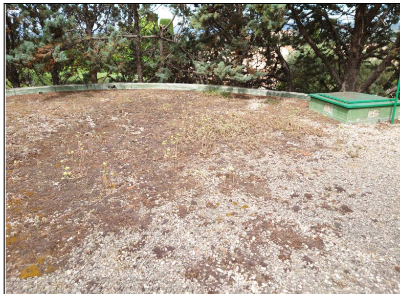
Toit de la cuve
