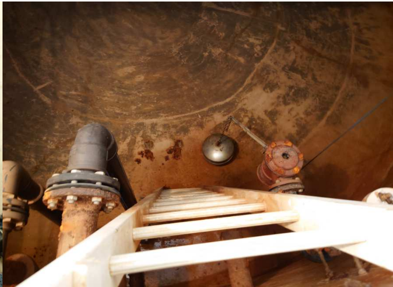
Vue intérieure de la cuve
