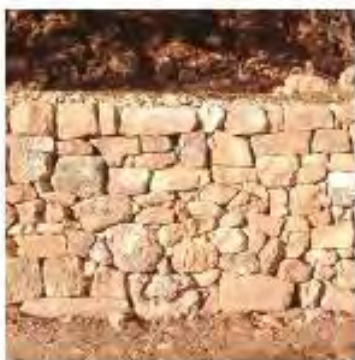
Mur de restanque
